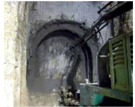
Posa in opera di spritz-beton fibrorinforzato al fronte
