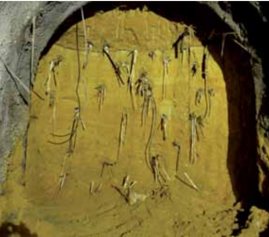
Particolare del fronte di scavo consolidato con Vtr iniettati in microfina
