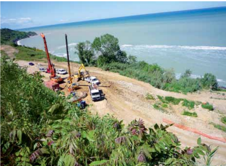
Lavori alla coronella di pali per la realizzazione pozzi di drenanti nel pendio in frana a nord
