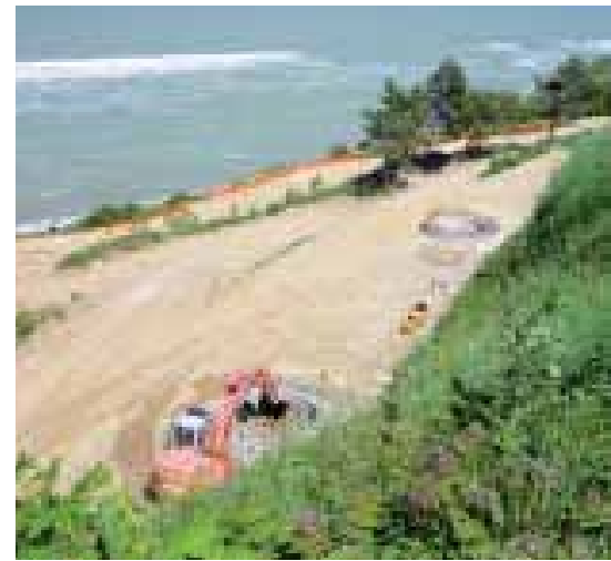
Vista dei pozzi drenanti realizzati sul pendio a nord
