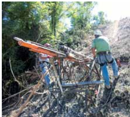
Esecuzione drenaggi sul costone in frana a nord
