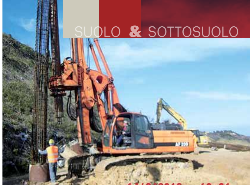
Lavori alla coronella di pali per la realizzazione pozzi di drenanti nel pendio in frana a nord
