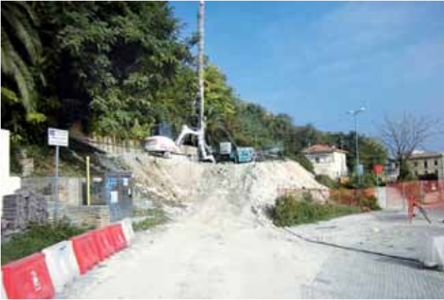
Trattamento con colonne verticali in jet-grouting sul costone a sud
