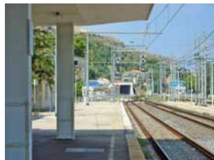
Vista dalla stazione di Ortona degli imbocchi sud della nuova galleria e, a destra, di quella esistente; sopra a sinistra, il castello
