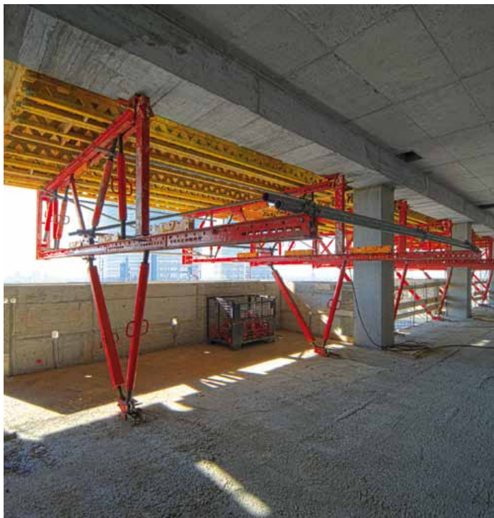
Travi a sbalzo ed elementi del sistema modulare PERI disponibili a noleggio, hanno sostenuto il peso del calcestruzzo fresco dei balconi e hanno avuto la funzione di parapetto di protezione per i due piani più alti. (Foto: PERI GmbH)
